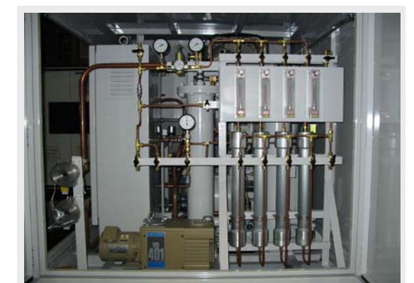
液化回収精製装置(空気成分、水分、油分、分解ガス等)
