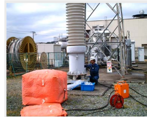
コロナ試験設備からのSF6の回収(SF6回収量:12kg)
