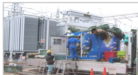
電力変電所でのSF6回収
