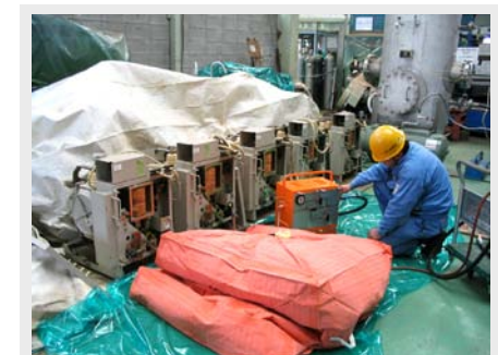
小型SF6開閉器(5台)からコンバスSF6回収装置でSF6を回収。封入量:30~150リットル/台
