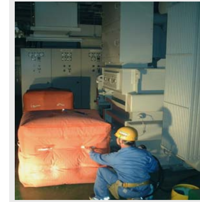
地下変圧設備のSF6回収
