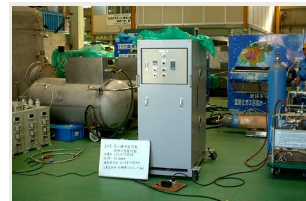
顧客殿SF6回収タンク(左)露点回復装置(右) SF6ガスの精製(空気、油分、水分)と回収ガスの液化回収・充填作業
