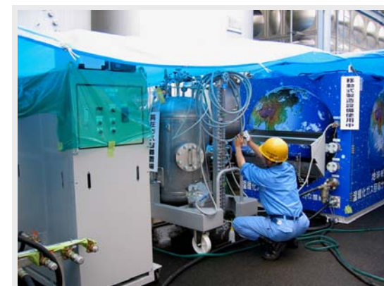
SF6露点回復装置DPR-50(左) 空気分離装置GLS-300(中央) SF6 液化回収装置(右)
