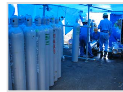
精製したSF6液化回収容器の計量、純度計測作業
