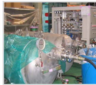
SF6循環精製装置
