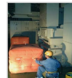
地下特高設備のSF6回収
