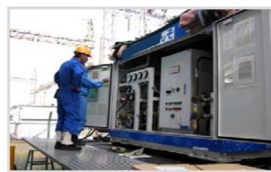
発・変電所でのSF6回収
